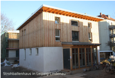
Strohballenhaus in Leipzig-Lindeneu
