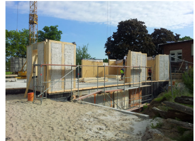
Bildquelle: Architekten f. Nachhaltiges Bauen GmbH
